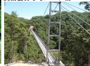
舌震の“恋”吊橋
